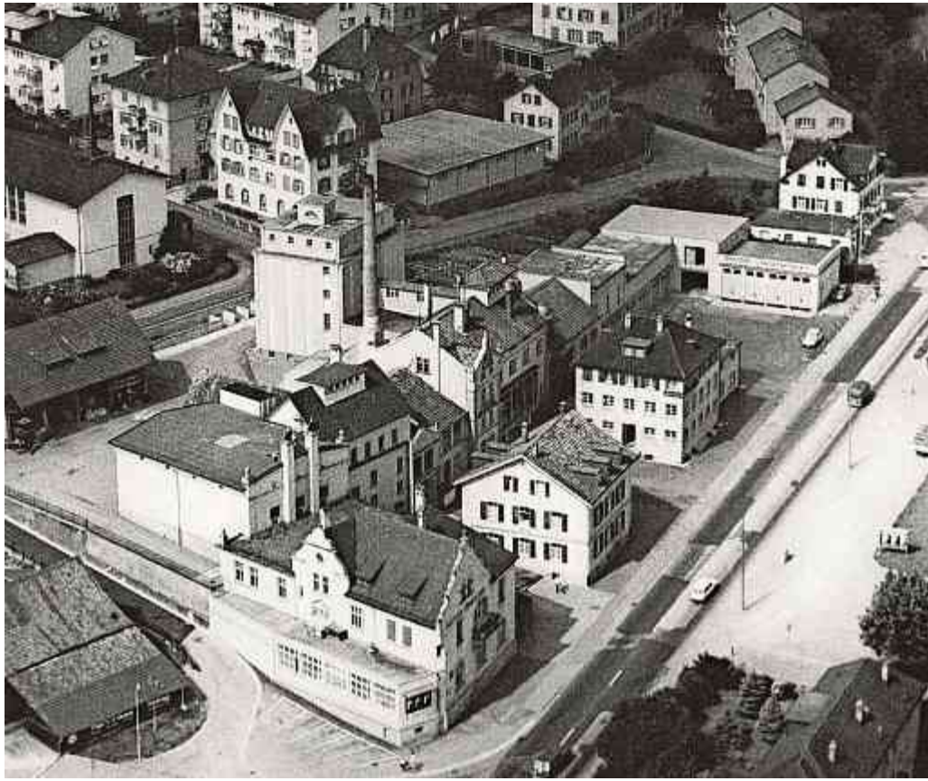
Das alte Abfüllereigebäude (unten in der Mitte) soll trotz Neuüberbauung erhalten bleiben.
