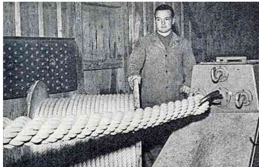
Eine der letzten Spezialarbeiten der Seilerei Wisiak, ein Seil mit 120 Millimeter Durchmesser und einer Reissfestigkeit von 60 000 Kilo. Bild: Koch (Rorschacher Monatschronik 1955)
